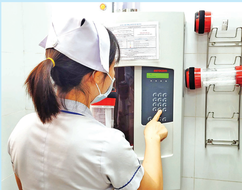
Nhân viên y tế khoa Nội tổng hợp đang thao tác chuyển mẫu đến khoa Vi sinh để xét nghiệm bằng hệ thống vận chuyển mẫu khí nén
