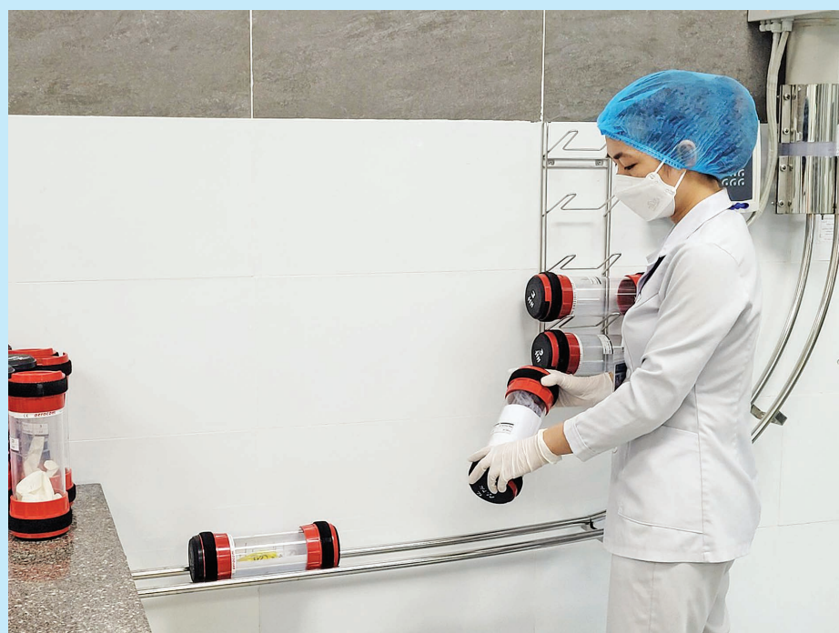
Mẫu xét nghiệm được chuyển đến khoa Vi sinh thông qua hệ thống vận chuyển mẫu bằng khí nén và được nhân viên y tế tiếp nhận để thực hiện xét nghiệm
