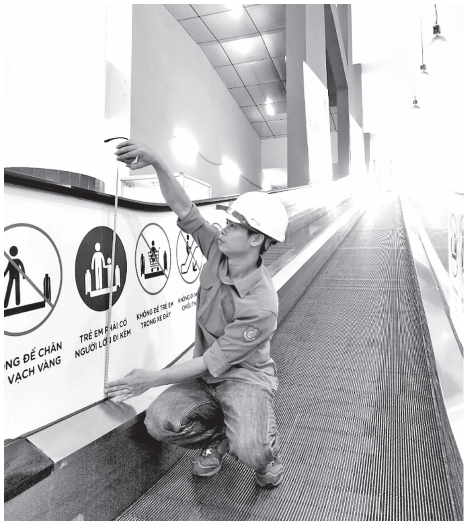
Kiểm định an toàn bằng tải chở người tại siêu thị BigC Đồng Nai
