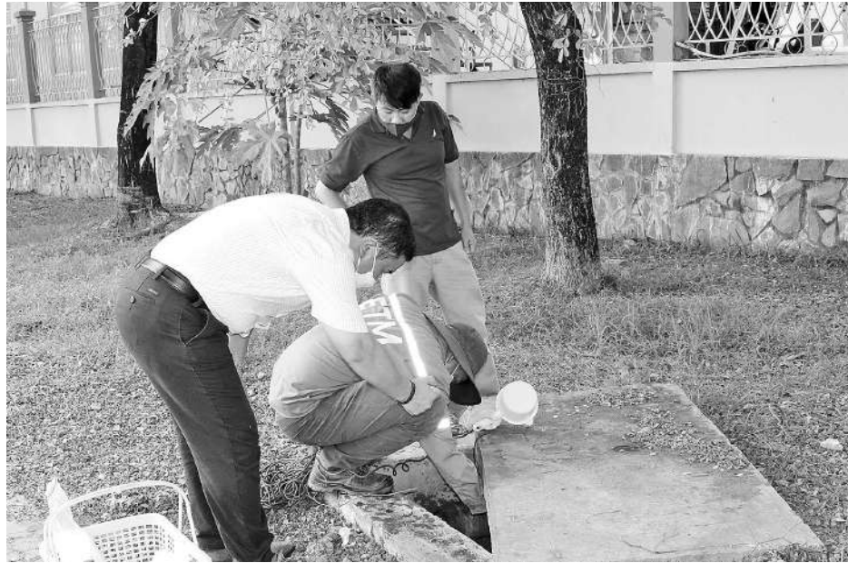
Đoàn công tác liên ngành của tỉnh kiểm tra hệ thống thoát nước mưa và nước thải tại Khu công nghiệp Agtex Long Bình (TP.Biên Hòa)
