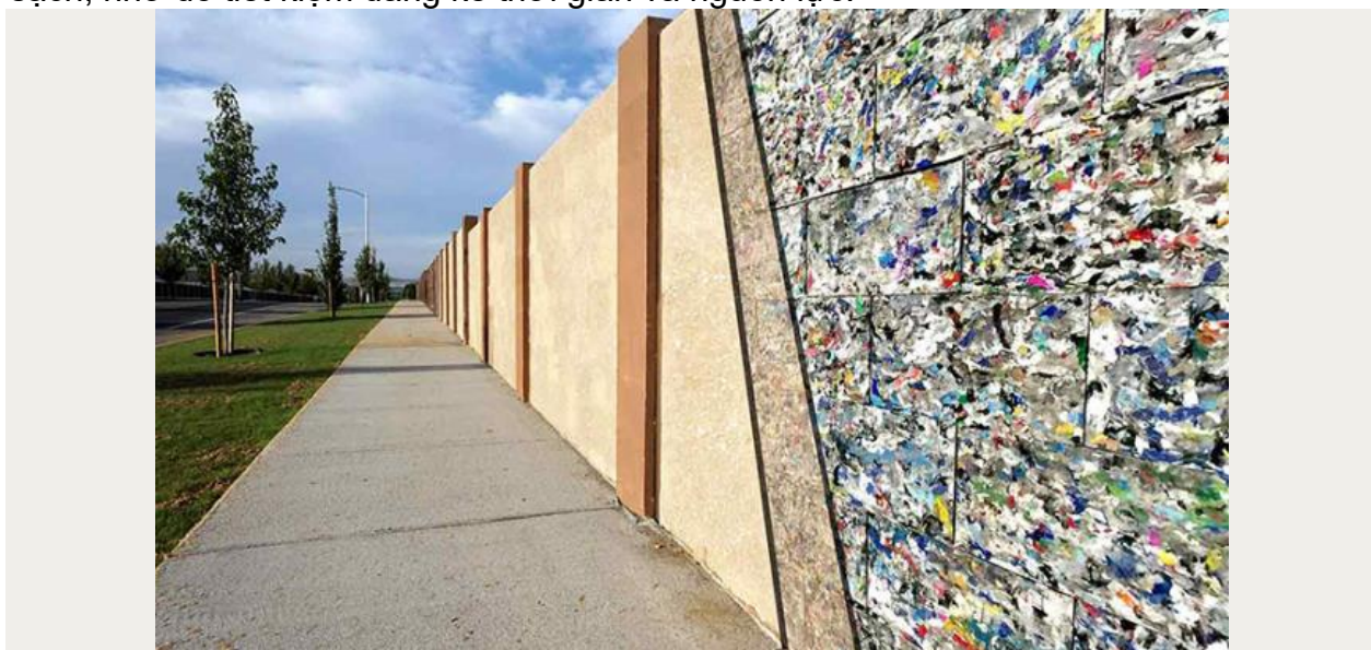
Một phần tường rào được xây bằng ByBlock. Ảnh: ByFusion
