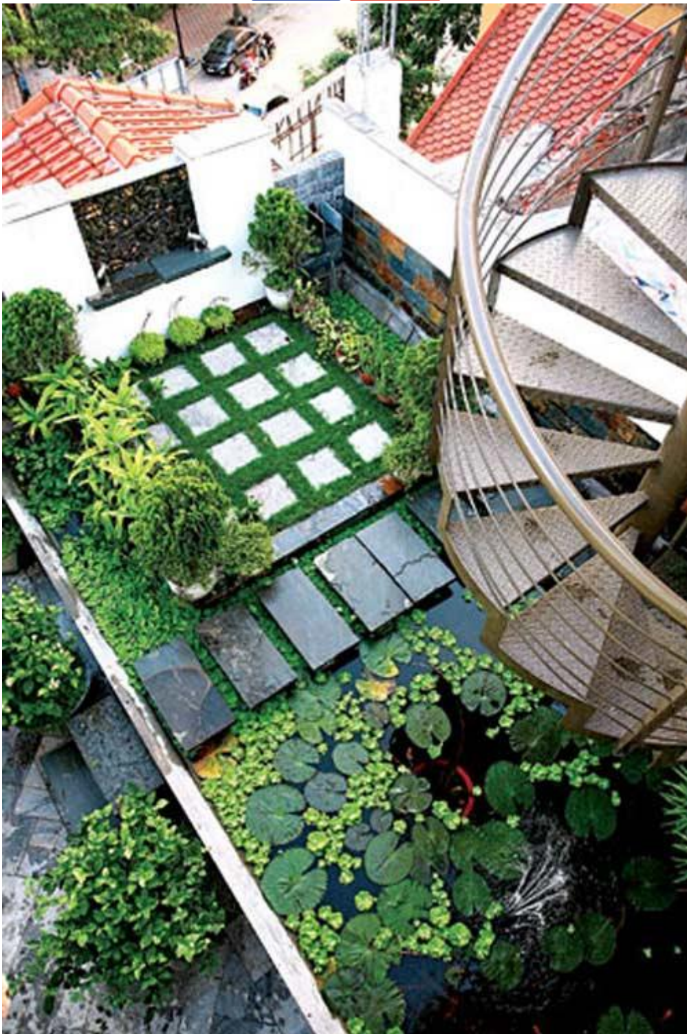
Vườn kết hợp với hồ cảnh trên mái có tác dụng chống nóng rất hiệu quả.
